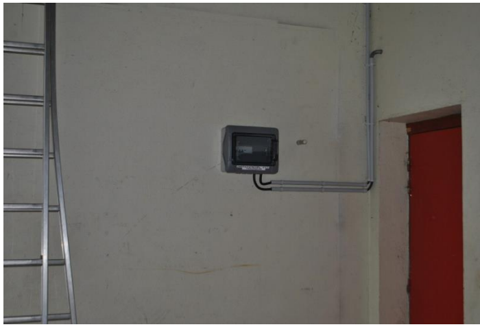
Coffret Différentiel Prise P17 32A Tétra
